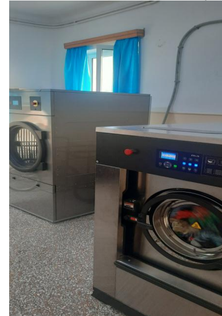
Δημιουργία χώρου πλύσης ιματισμού
